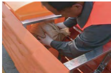
۶۸-۸- قراردادن ضربه گیر آلومینیومی
