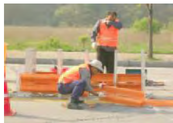
۶۸-۶- نصب دیواره‌ی ضربه گیر
