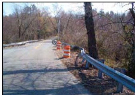
تصویر ۵۰: گذاشتن بشکه تا هنگام رفع خرابی نوع یک
