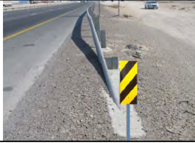
ب: بالی شکل کردن قسمت ابتدایی گاردریل
