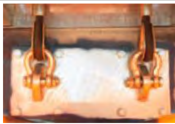
۶۸-۳- نصب صفحه و بولت بر روی میل مهار
