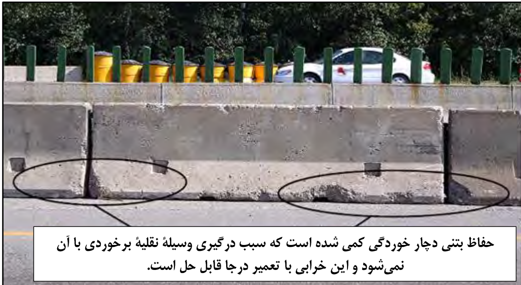
تصویر ۱۶: نمونه‌ای از خوردگی حفاظ بتنی که قابل تعمیر در محل است
